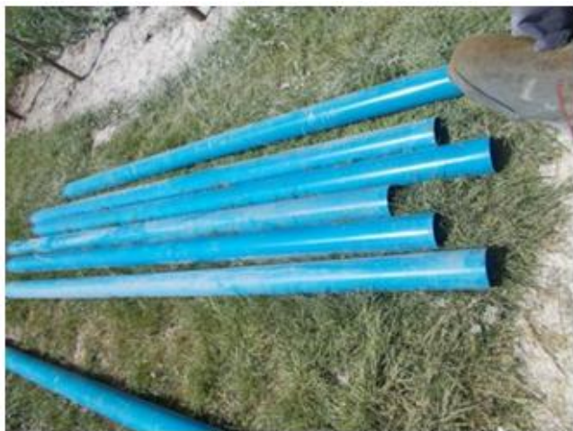
Vgrajene PVC cevi
